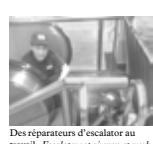
Des réparateurs d'escalator au travail. Escalator repairmen at work
